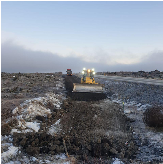
Frá framkvæmdum við lagningu 1. áfanga göngu- og hjólastígs. Fyrsti áfangi er á milli Reykjahlíðar og Dimmuborga. Mynd: Helgi Héðinsson.
